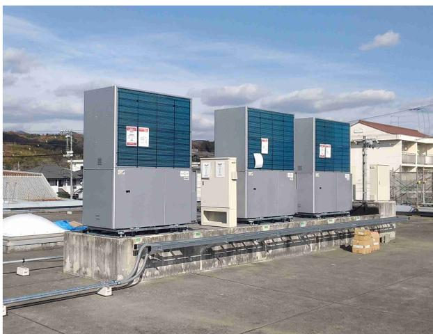
停電対応型ガス空調機（室外機）
